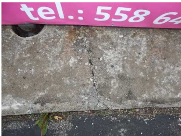
Trhlina v římse.
