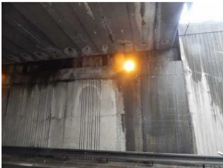
Zatékání na opěru 1 vlevo.
