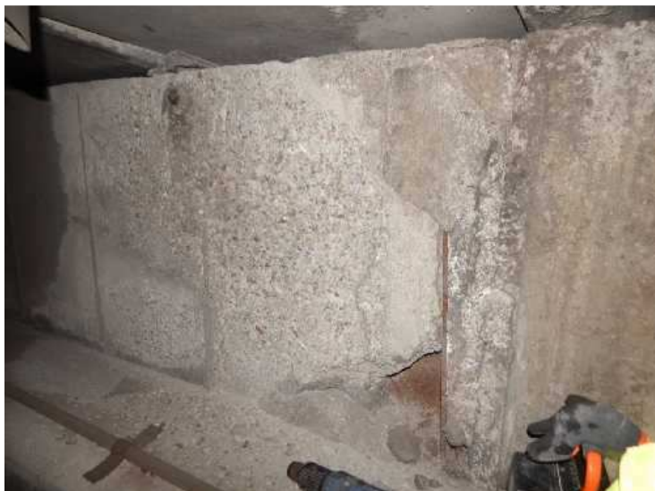
Obnažená výztuž úložného prahu.
