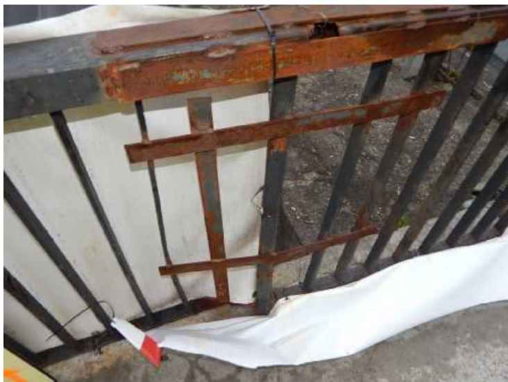
Koroze zábradlí v místě opravy.
