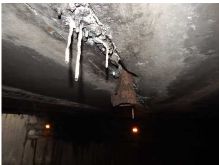
Zkorodovaný odvodňovač. Zatékání s výluhy mezi nosníky.
