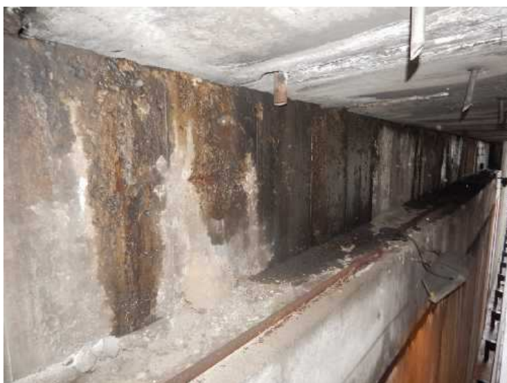
Zatékání na úložný práh opěry 1.
