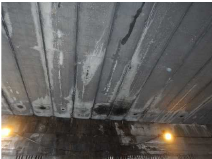
Zatékání na podhledu nosné konstrukce.
