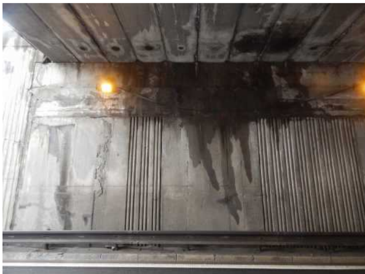
Zatékání na opěru 2 vlevo.
