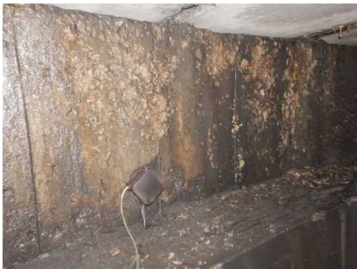
Degradace betonu úložného prahu.
