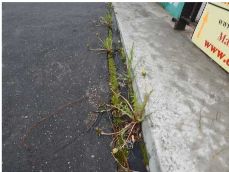
Vegetace ve spáře mezi římsou a chodníkem.
