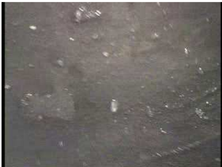
Dutina D4, nosník N5, dutina vlhká, uvnitř dutiny menší množství vody
