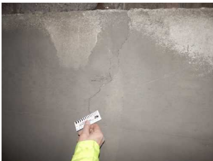
Svislá trhлина v dříku opěry 1.
