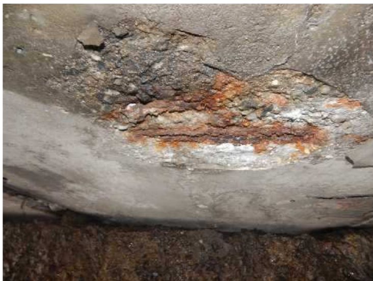
Obnažená korodující výztuž nosníku.
